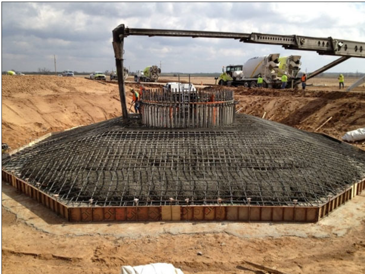
Obrázok 8: Teleso základov veternej elektrárne z armovaného betónu
